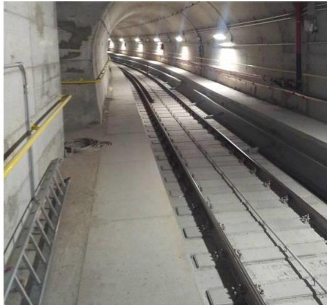
L'intensità delle vibrazioni immesse nel terreno **può essere ridotta con interventi alla sorgente**, ad esempio con la scelta di un **particolare tipo di armamento ferroviario**.
